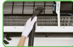
Bước 4: Vệ sinh tấm lọc & dàn tản nhiệt
