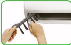
Bước 2: Vệ sinh cánh đảo gió
